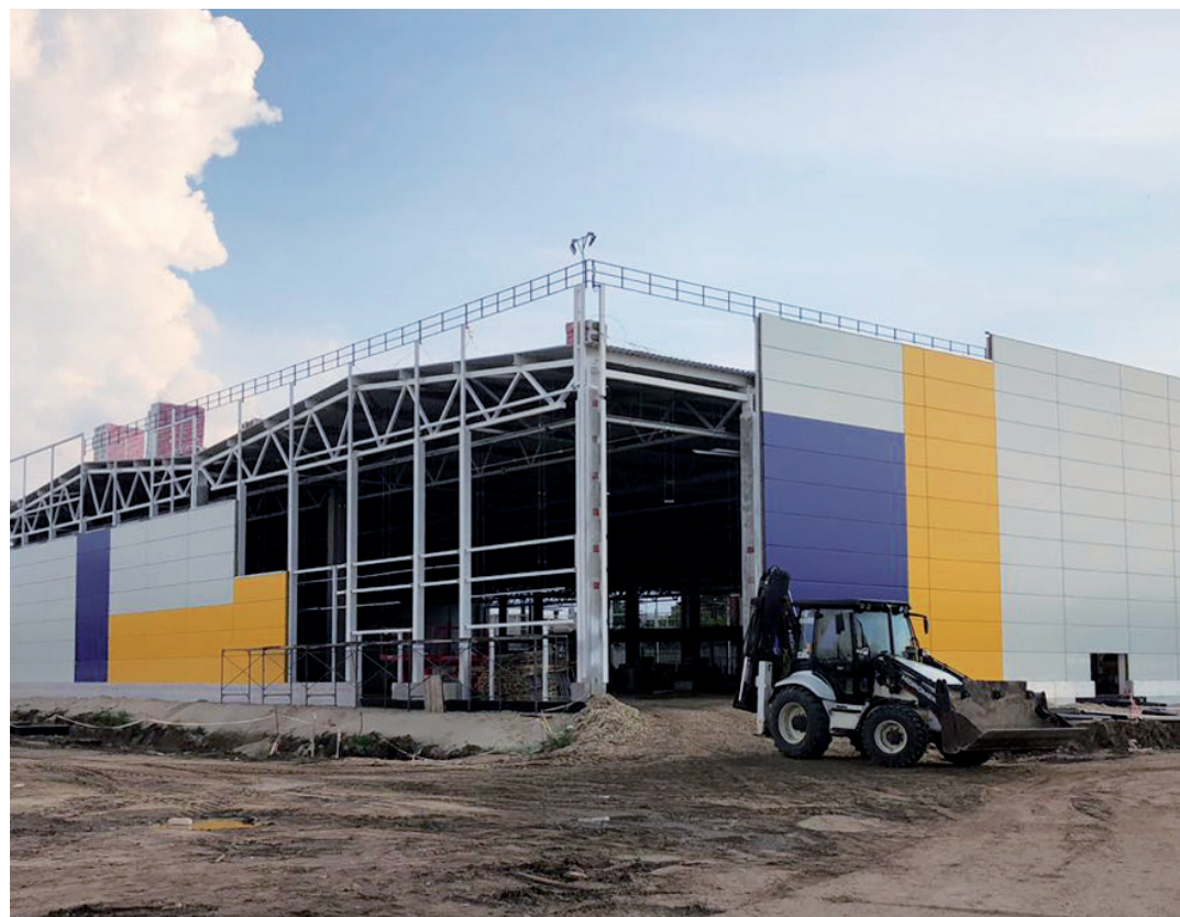
Монтаж фасадной системы FRONTTOP
